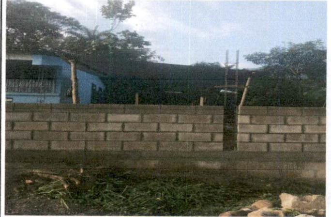
Foto 2: Se está realizando mejoramiento de muro perimetral e instalación de puerta de metal para ingreso al área de sanitario.
