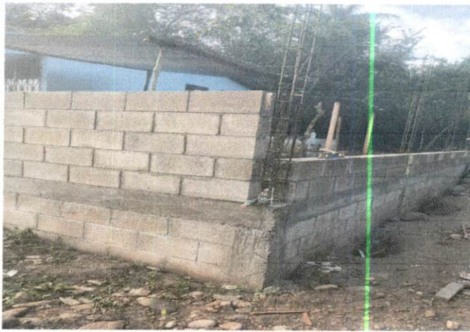
Foto 1: Se está realizando mejoramiento de muro perimetral.
